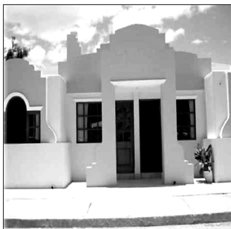
Figura 2. Casa Materna del Hospital San Luis de Otavalo. Fuente: MSP 2010c, 85.
