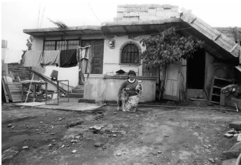
Imagen 12. Una 'villita' en construcción, Cooperativa Santa Anita
