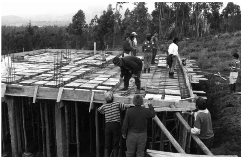
Imagen 20. Minga para la construcción del techo
