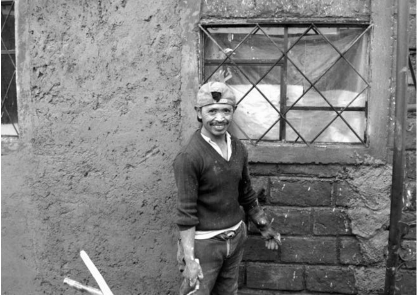
Imagen 28. Atención para el acabado de fachada
