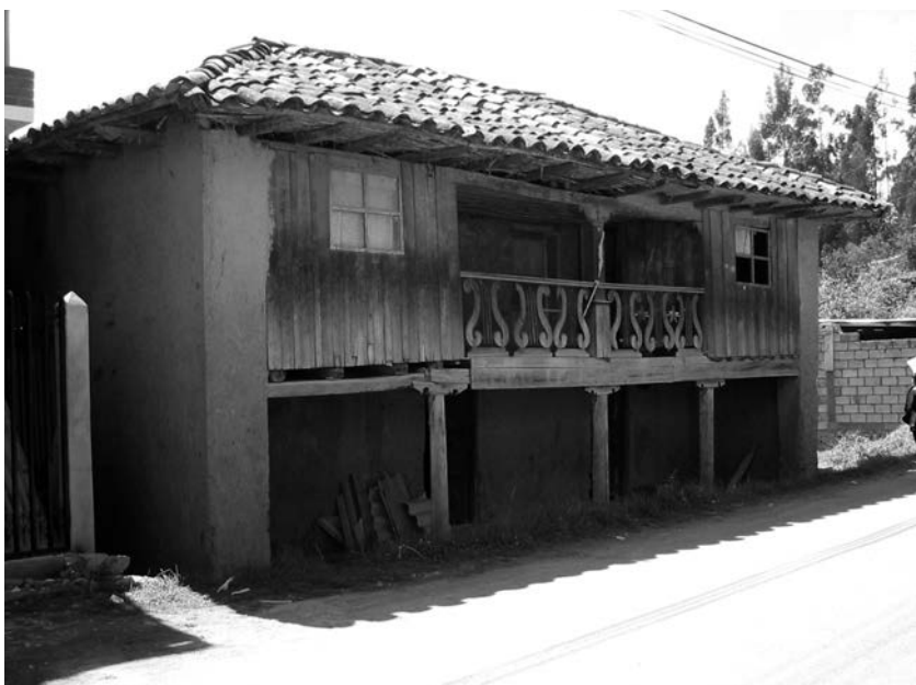
Imagen 33. Arquitectura rural tradicional cerca de Cuenca: casa de adobe con techo de teja y balcón con talla en madera.
