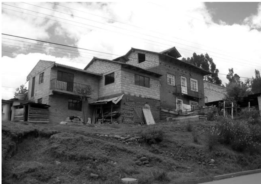
Imagen 27. Tendencias antiguas (izquierdo) y nuevas (derecha) en marcos de ventana, Ciudadela Carlos Crespi.
