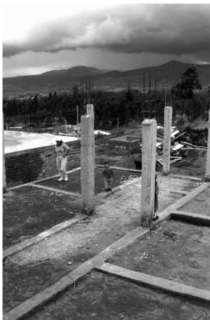
Imagen 19. Primera fase de construcción: cimientos y columnas
