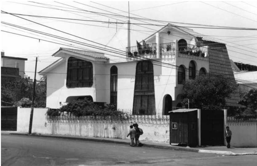
Imagen 26. Fachadas y techos inclinados, Riobamba
