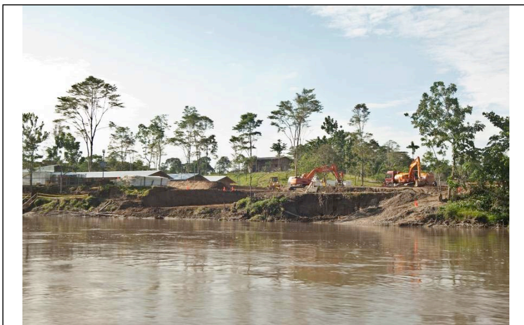
Fotografía tomada en noviembre del año 2009 a orillas del río Aguarico en el límite de la Reserva Cuyabeno, donde PetroAmazonas ha iniciado trabajos para construir una vía de acceso que atraviesa el Bosque Protector Pañacocha para explotación de crudo.
