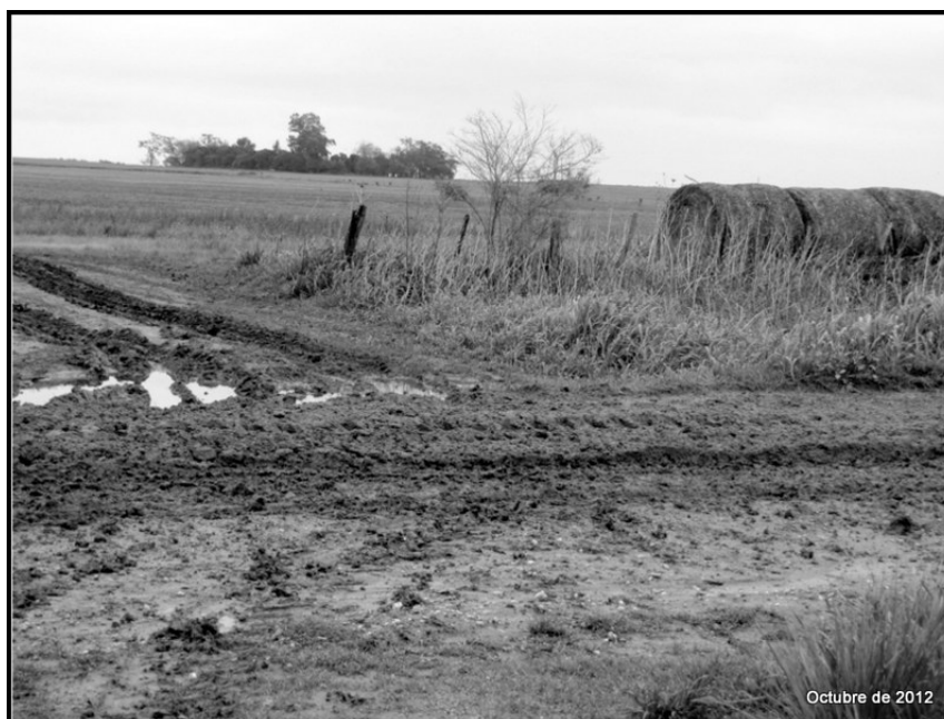
Anexo N° 4: Intersección del camino principal y un callejón de salida de una de las unidades. Luego de dos días lluviosos el barro acumulado dificulta el tránsito y genera huellones .
