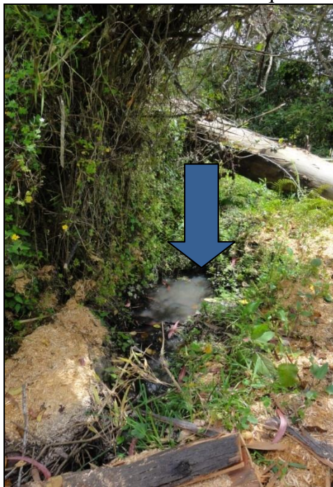
Foto N.º 4. Estado actual de la acequia de Pisquer
