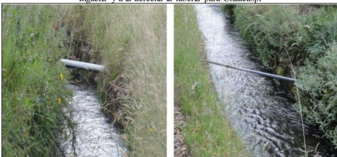
Foto N.º 3. Tuberías de distribución de agua potable. A la izquierda la tubería para Ingueza y a la derecha la tubería para Chitacspi
