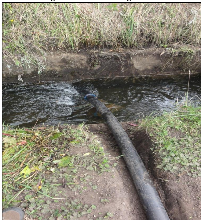
Foto N. ° 7. Toma de agua a través de manguera desde el canal San Isidro
