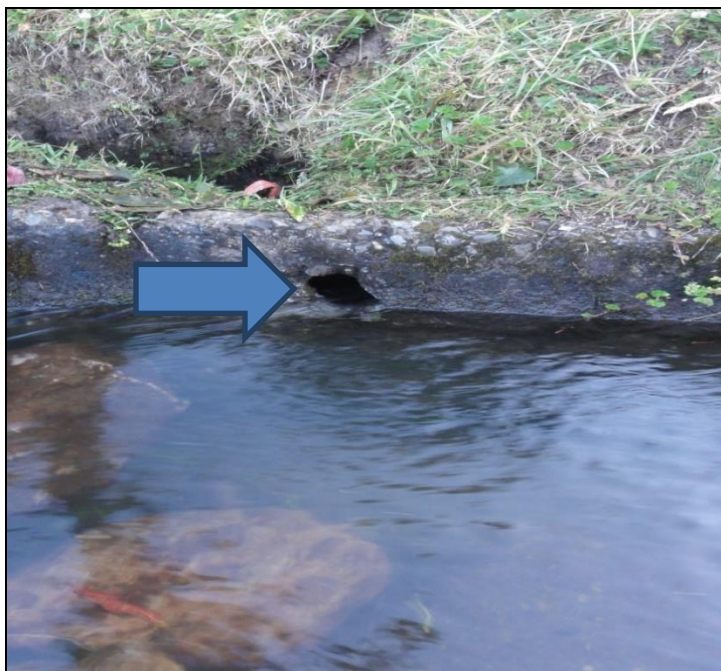
Foto N.º 10. Rotura del canal San Isidro
