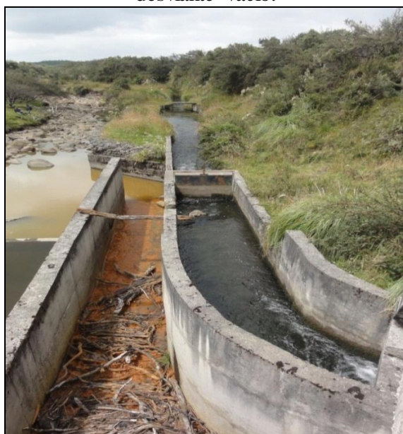
Foto N.º 6. Estado boca toma Canal de San Isidro (Agosto, 2012), izquierda el desviante vacío.
