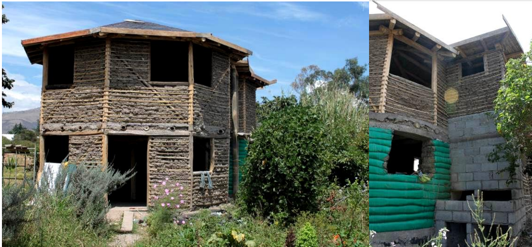
Fotografía 3. La casa en construcción de la Familia Simbaña – Guamán. Se levanta al lado de la Chakra mediante técnicas de Bioconstrucción como paredes de bahareque y superadobe (en verde), y cámaras para descomposición de baños secos aboneros (en bloque) (Fotografiado por el autor).
