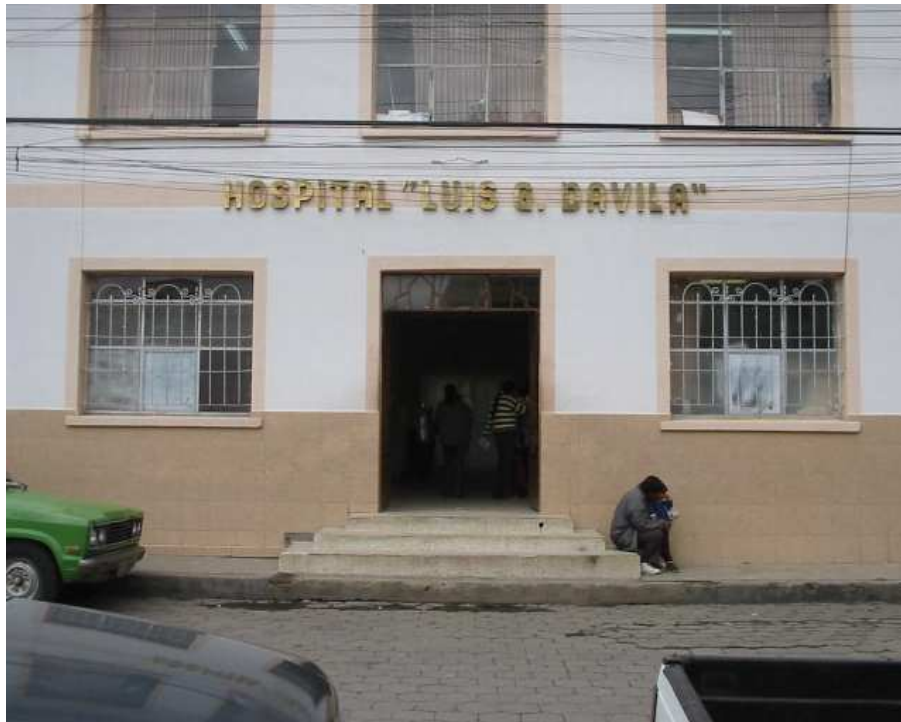
Ingreso del hospital no cuenta con rampas para camillas
