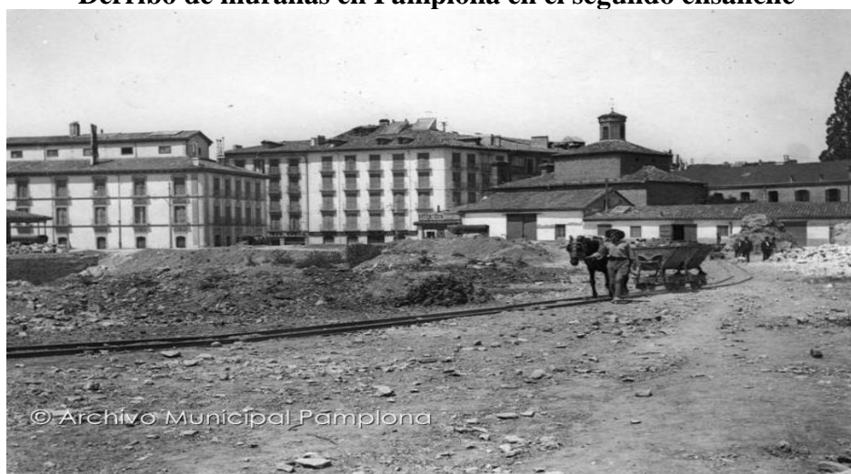
Imagen 4 Derribo de murallas en Pamplona en el segundo ensanche
