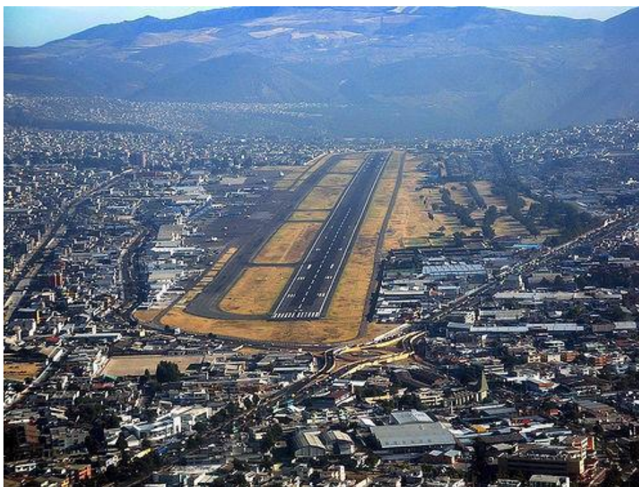
Fuente: MDMQ, 2011 Vista panorámica del antiguo aeropuerto Mariscal Sucre de Quito
