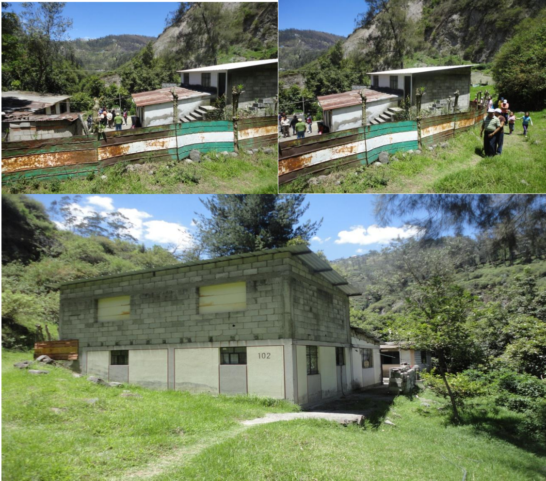
Fotografías de la vivienda que se encuentra con el peligro de colapso de escombros y al borde del Río Machángara
