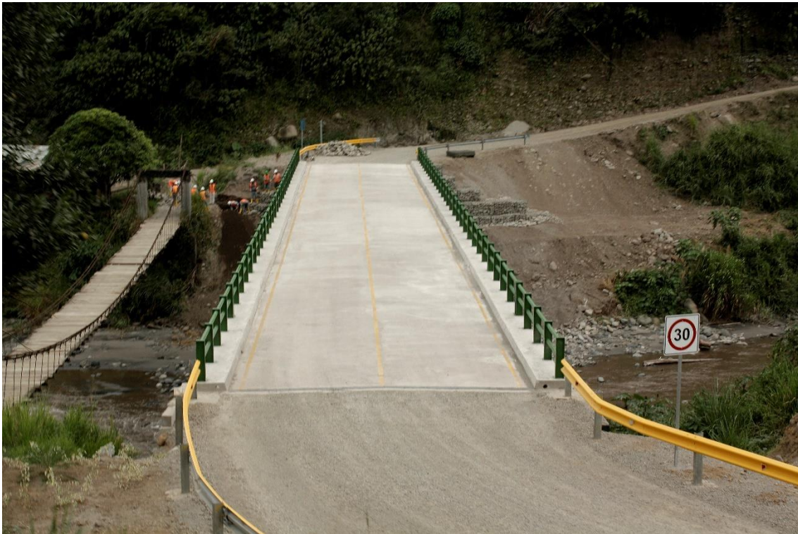
Figura 4.2. Construcción Puente “Gringo Pepe”
