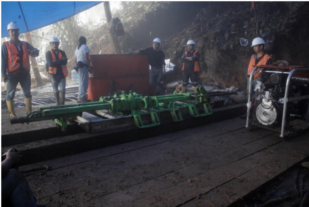
Figura 4.6. Instalación plataforma 1. Zona de reserva comunitaria
