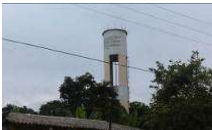
Tanque reservorio de agua alimentada por pozos someros
