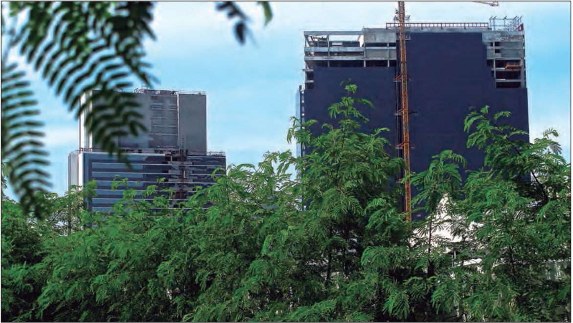
Parque Olímpico. Desde la "ciudad vieja", los habitantes de Vila Autódromo pueden observar el avance de las obras del Parque Olímpico por sobre la cerca que los divide.
