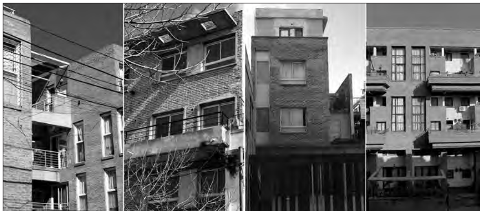
Imagen 1. Fachadas de ladrillo descubierto y hormigón, CABA 2013
